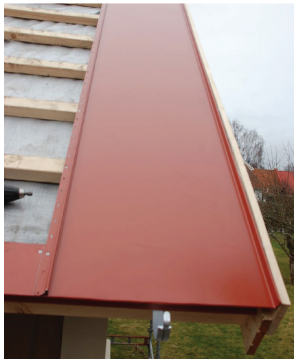
Lägg första takplåten från valfri sida
